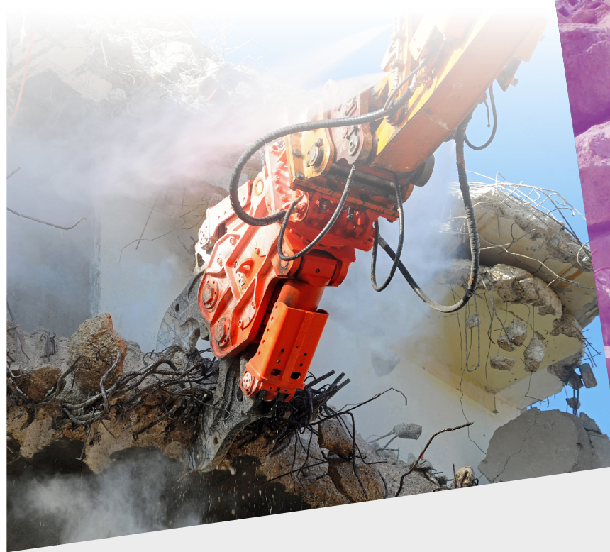
▲ Démolition à l'aide d'une tenaille
