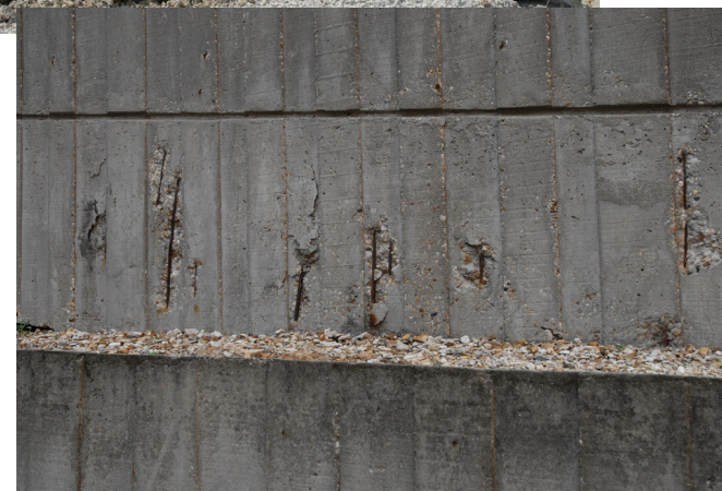
▲ Exemple de pathologies (épaufrures) sur béton armé dues à la corrosion des armatures induites par carbonatation.
