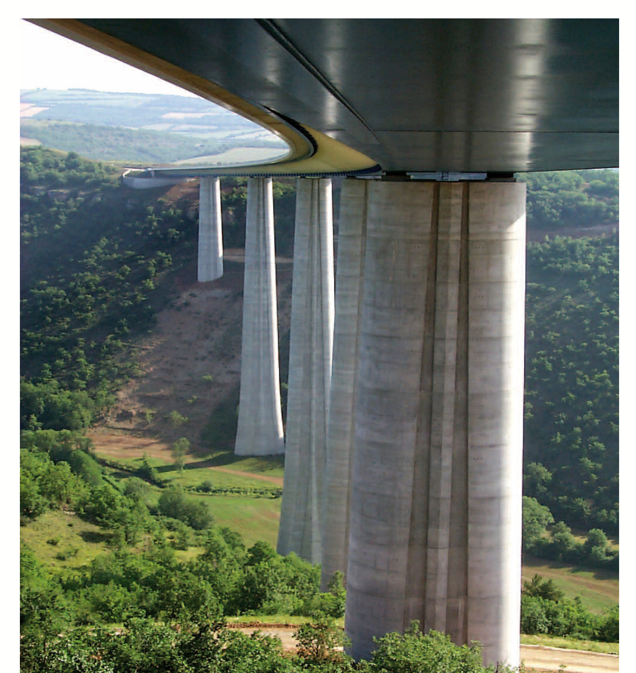
Pile du Pont de Verrière
