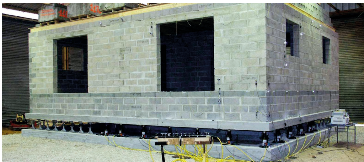
Maison prototype instrumentée construite à Rouen pour les besoins du projet ARGIC2
