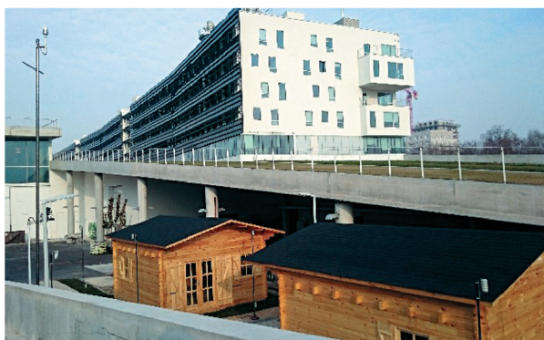
Vue d'ensemble de l'instrumentation déployée sur site
